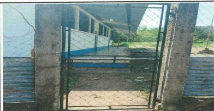
Foto 5: Reparacion de porton.
