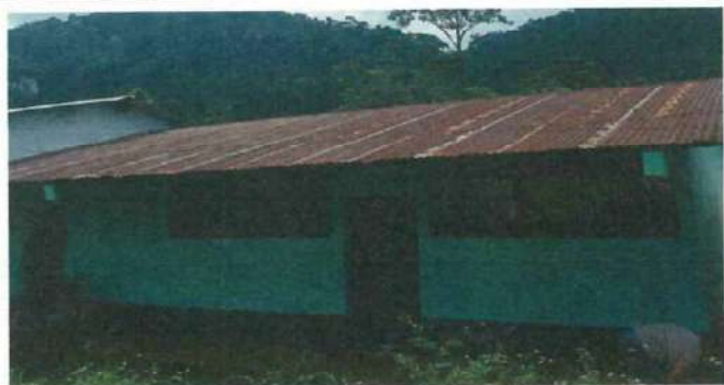
Foto 3: Cambio de techo por deterioro.
