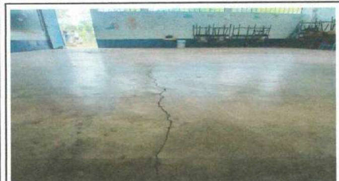
Foto 3: Cambio de piso.
