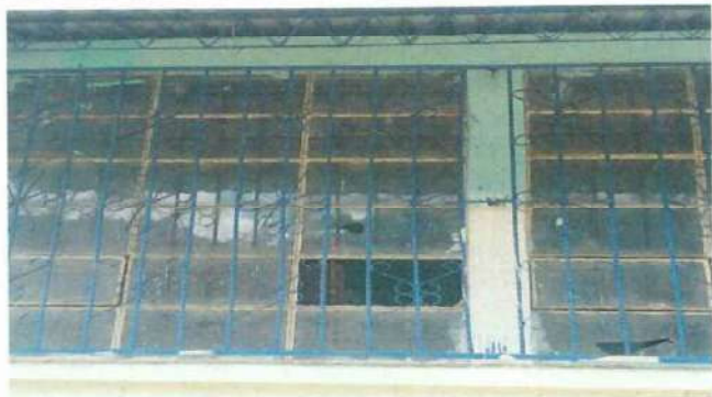
Foto1: Cambio de vidrios.
