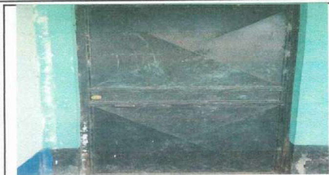
Foto1: Cambio de puertas.
