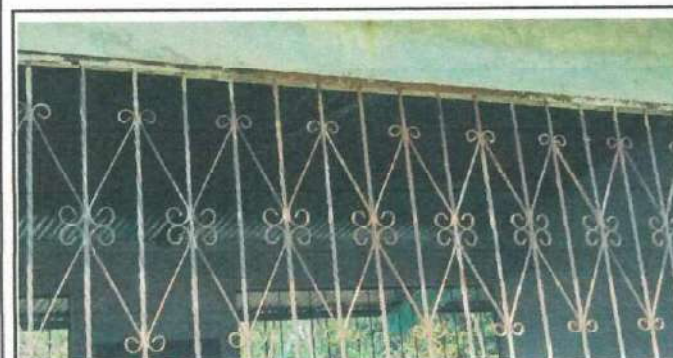
Foto 5: Pintura de Balcones
